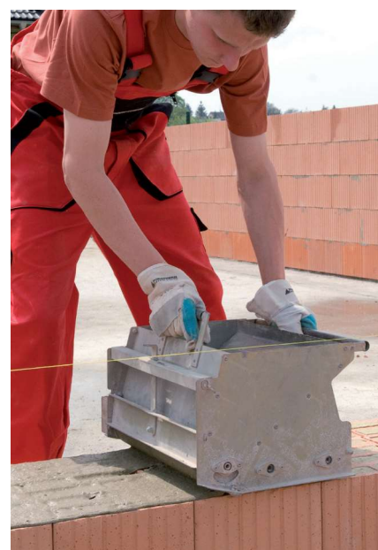
Nanášení maltovacím vozíkem na celou plochu ložné spáry
